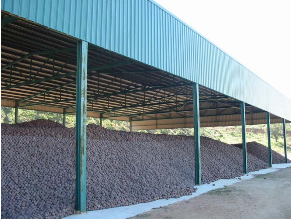
Nave de almacenamiento de piña
